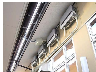
パワーコンディショナー 太陽光パネルで発電された直流電力を家庭等で使っている交流電力に変換する機器
