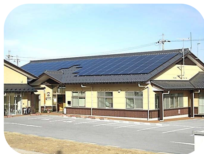
本館の屋根に設置された太陽光パネル
