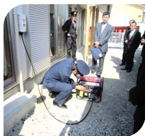
非常用発電機
