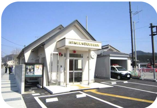
モダンな建物になった駐在所
