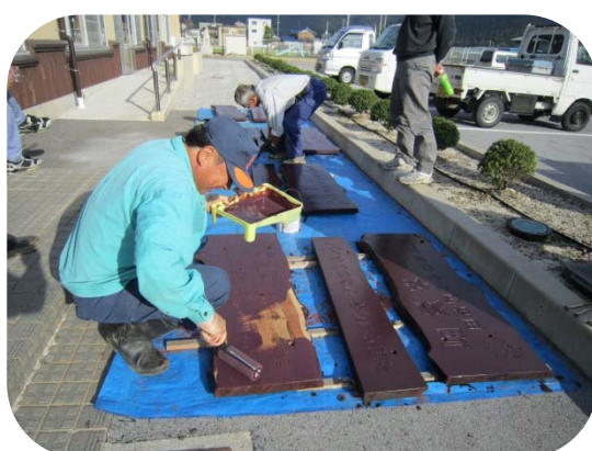
ローラー刷毛で全面に塗装作業
